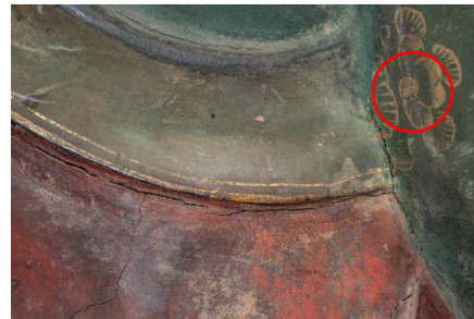
DN7 (測定箇所)
